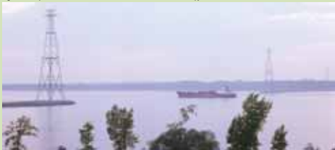
Ligne de transport de l'électricité à Grondines avant le démantèlement des pylônes
